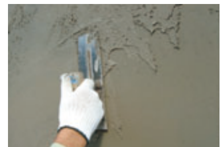
全面補修[NSポリマーミックス#300]
