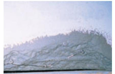
鉄筋防錆処理[NSメンテペースト]
