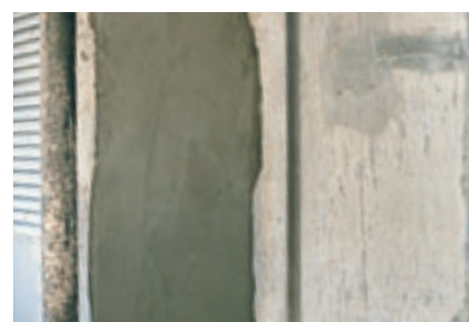
断面修復後[NSドカモルハード]
