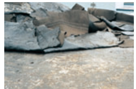
既存防水材の撤去
