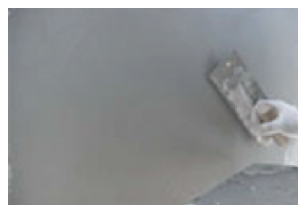
フィラー塗布2回目[GNSフィラー]
