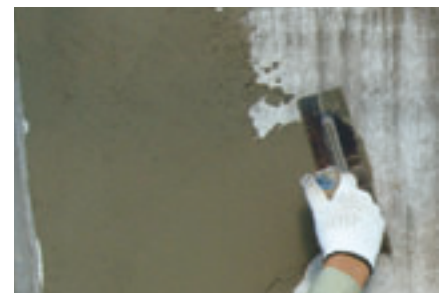
壁全面補修[NSポリマーミックス#300]
