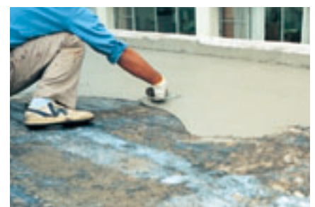
下地調整[NSカチオンワン塗付け]
