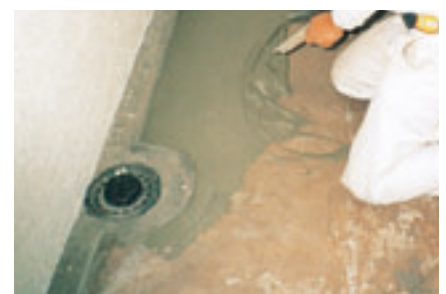
床全面補修[NSポリマーミックス#20]
