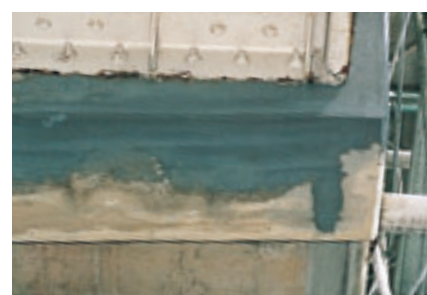
断面修復後[NSドカモルハード]
