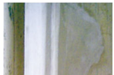
断面修復後[NSドカモルハード]
