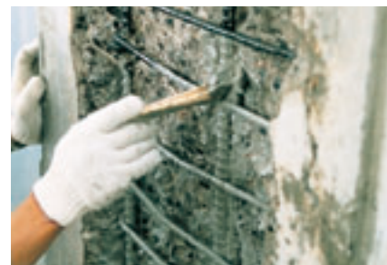
鉄筋防錆処理[NSメンテペースト]
