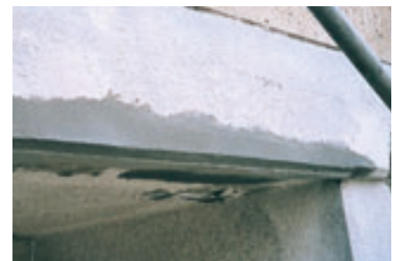
断面修復後[NSドカモルハード]
